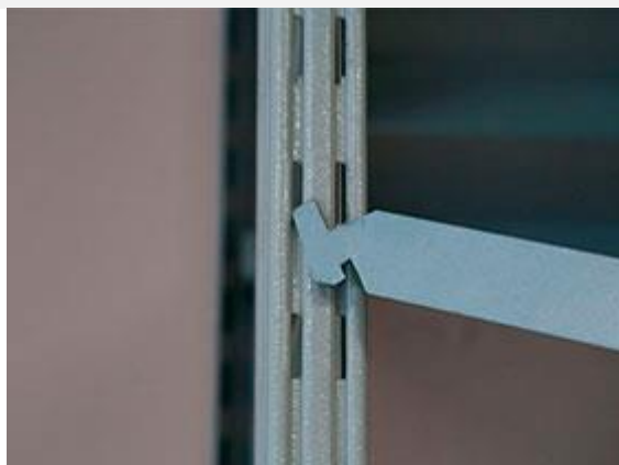
Расположение кронштейна относительно стойки.
