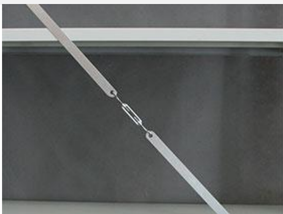
Соедините две растяжки талрепом и затяните его.
