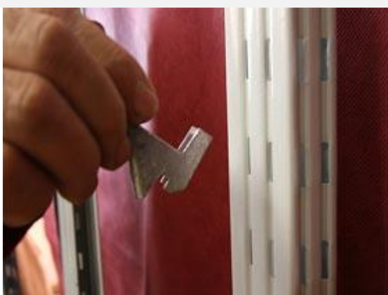
После сборки рам необходимо установить клипсы для крепления полок на необходимой вам высоте.
